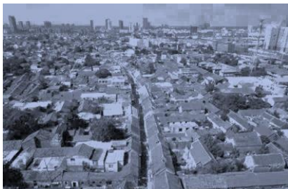
濉溪县 2018 年街巷整治工程
