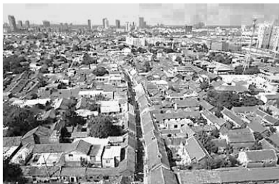
濉溪县 2018 年街巷整治工程
