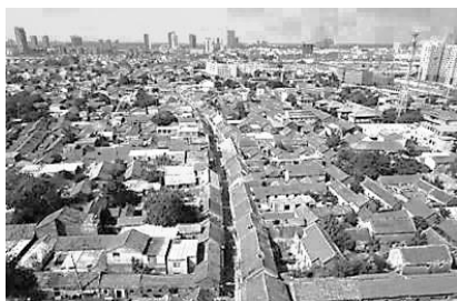
濉溪县 2018 年街巷整治工程
