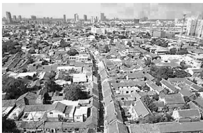
濉溪县 2018 年街巷整治工程
