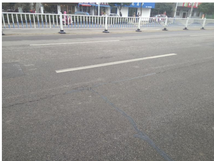
反射裂缝
