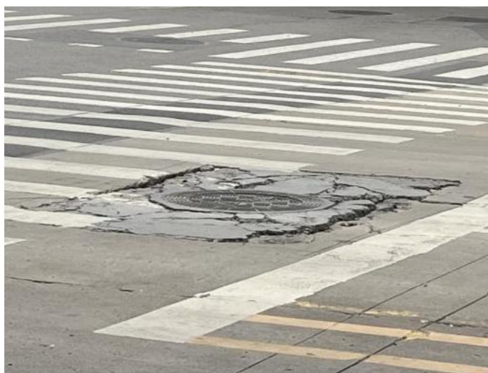
检查井边砼路面破损
