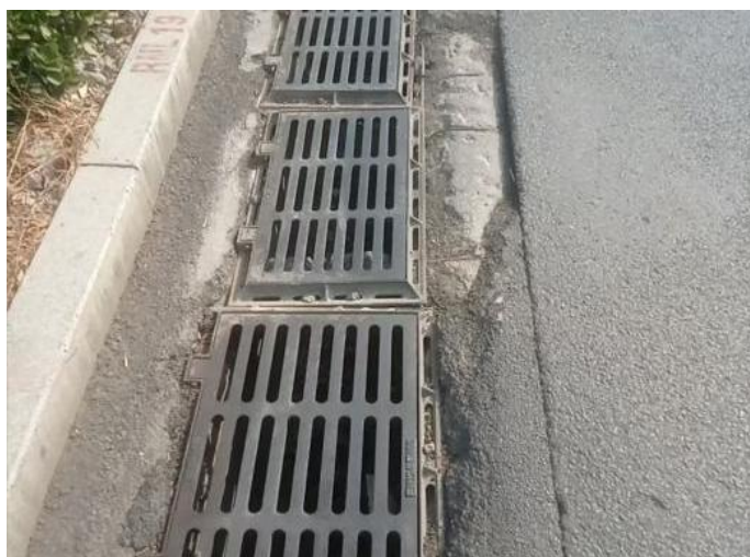
雨水井周沥青路面破损
