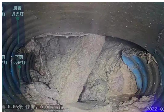
管道变形破损
