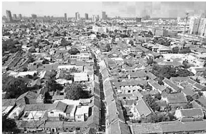
濉溪县 2018 年街巷整治工程
